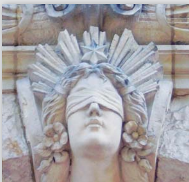
Wenn es um Schäden durch Schlaglöcher geht, sieht Justitia künftig genauer hin.
